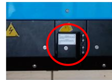
Erdungsschalter (Hauptstromrichter rechts, Deckel geschlossen)
