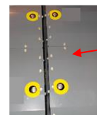
Auslassöffnungen Druckentlastung Wasserstoffspeicher (zur Übersicht ohne Hauben dargestellt)
