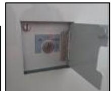
Für eine komplette unmittelbare Abschaltung der Batteriespannung sind an beiden Bedientafeln in den Schaltschränken, jeweils im Eingangsbereich des ersten Einstiegs hinter dem jeweiligen Führerstand, in Richtung zu diesem gesehen rechts, jeweils die beiden Batterie-sicherungen zu ziehen. Sicherheitshandschuh verwenden!
