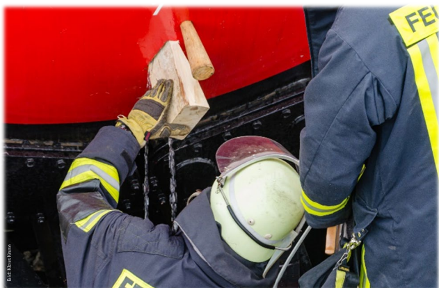
Abbildung 19: Abdichten eines Risses im Kessel
