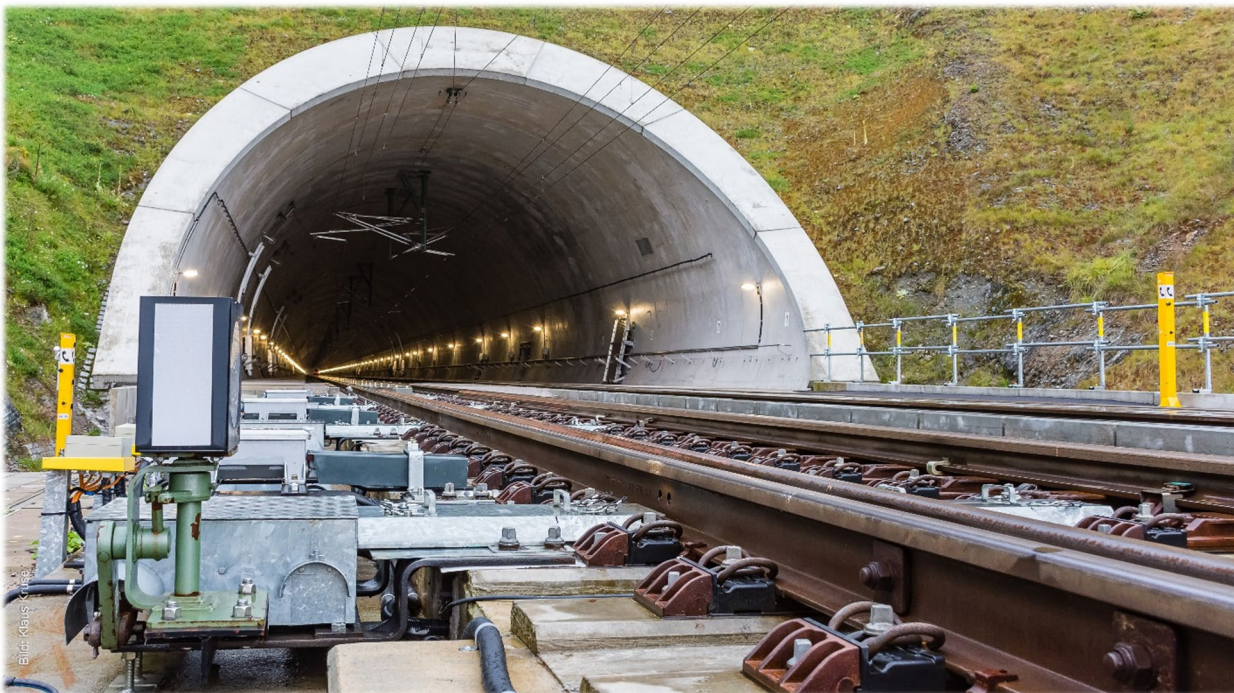
Abbildung 47: Südportal des einröhrigen Tunnels Fleckberg
