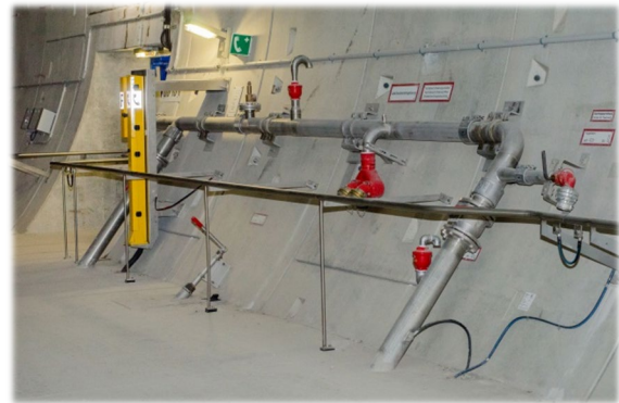
Abbildung 56: Überleiteinrichtung Löschwasserleitung (Beispiel)
