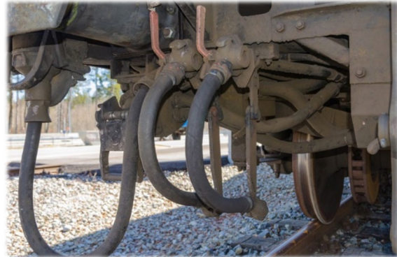
Abbildung 35: Luftleitungen mit Luftabsperrröhren
