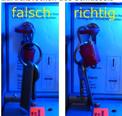
Um die Auslösung eines Sabotage-Alarms zu verhindern, sollte bei Schlüsseln die sich waagerecht in der *Sichern*-Position befinden folgendes beachtet werden:
