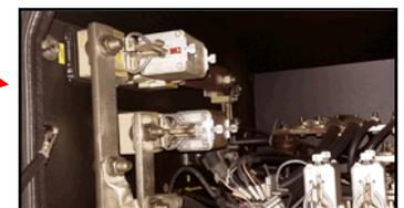
Hinweis: Das Ziehen der Batterieauptsicherungen darf nur mit Sicherheitshandschuhen und einer Sicherungszieheinrichtung erfolgen!
