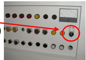
■ **Bei abgestellten Fahrzeugen Fremdeinspeisung 400 V trennen:**
